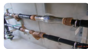
貯水タンクの入水管へ設置
